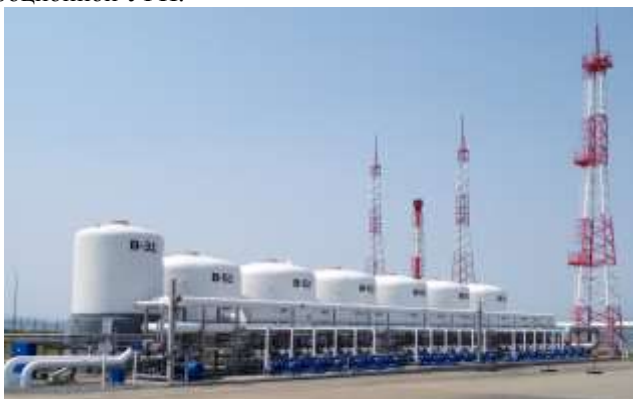
Рисунок 3 – Общий вид реконструированной УРП в ООО «Транснефть – Порт Козьмино»
