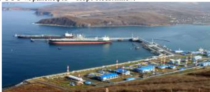
Рисунок 1 – Общий вид на площадку ООО «Транснефть – Порт Козьмино»
