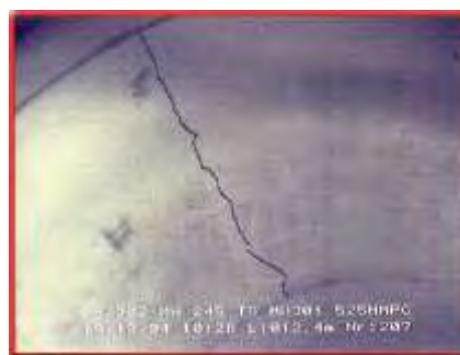
Фото 1. Образование поперечных и продольных трещин в обделке коллекторного тоннеля
