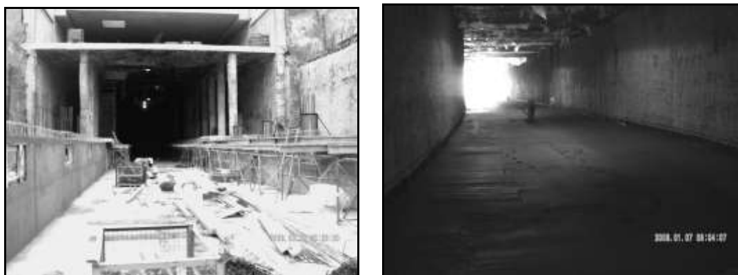
Рис. 1 и рис. 2. Внутренние конструктивные элементы, выполненные из шлицевых стен.
