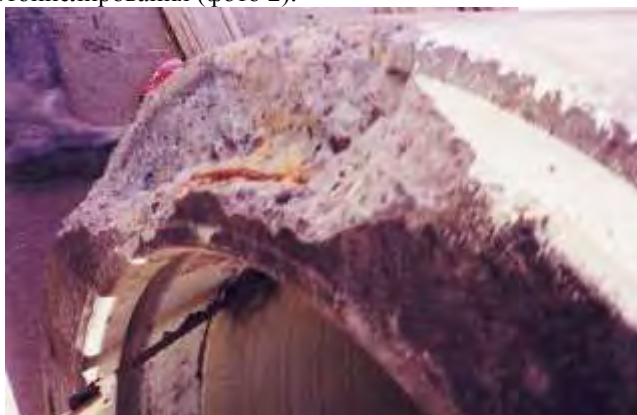
Фото 2. Разрушение торцевой части обделки в виде скола
