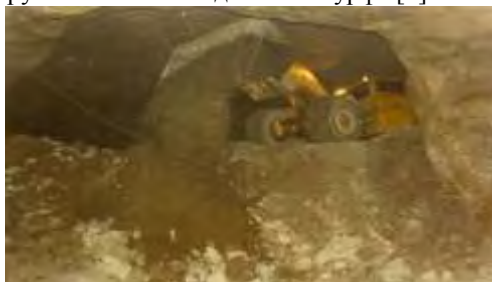
Рис. 7. Возведение закладки выработанного пространства [4]
