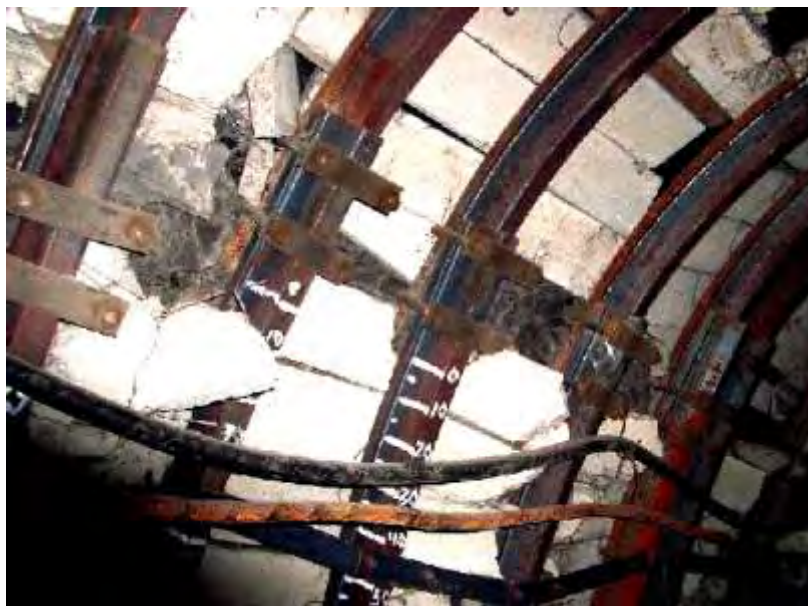
Рис. 1. Деформации железобетонных затяжек
