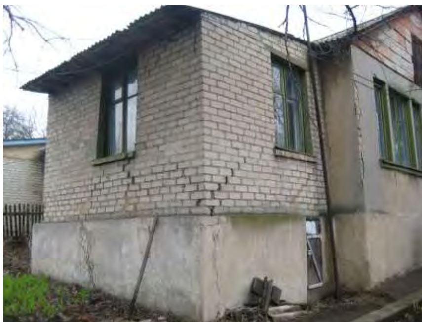
Рис. 1. Повреждения жилого дома в г. Кировское Донецкой области
