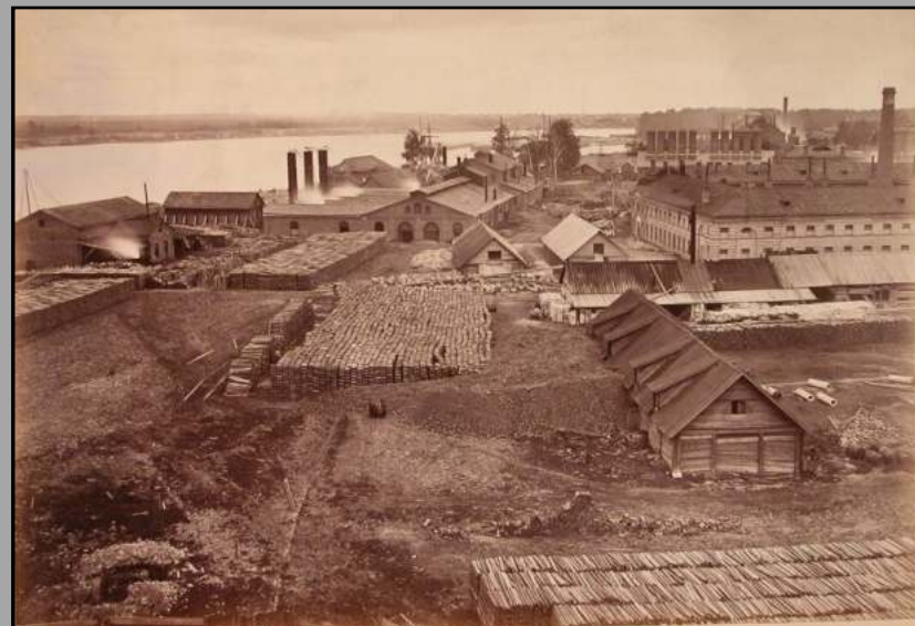
Общий вид зданий на территории завода
