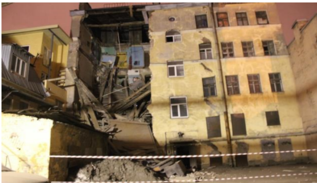
Рисунок 1.1 – Фото аварийного дома (Санкт-Петербург)
