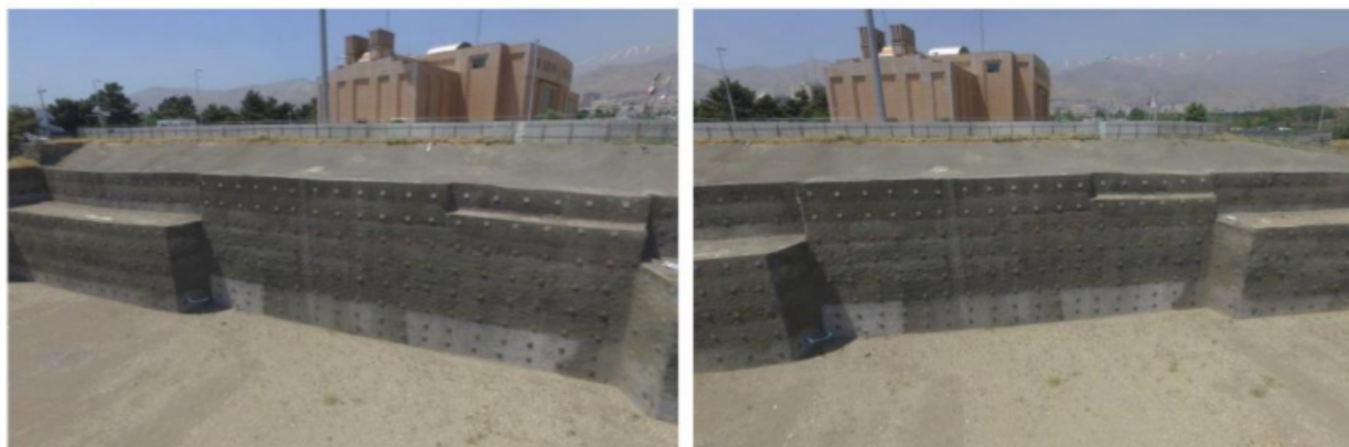
Рисунок 1.11 – Образцы наблюдений, снятые с использованием Phantom 3 Pro для мониторинга перемещений стен (Сеул)
