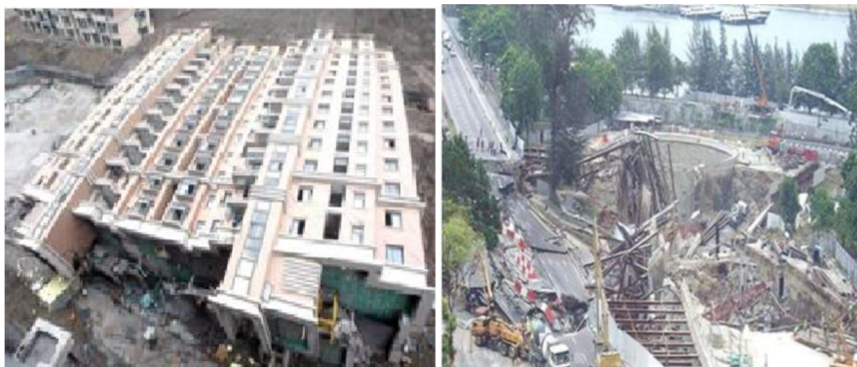
Рисунок 1.3 – а) Вид разрушения здания в Шанхае; б) Картина разрушений на шоссе Николл
