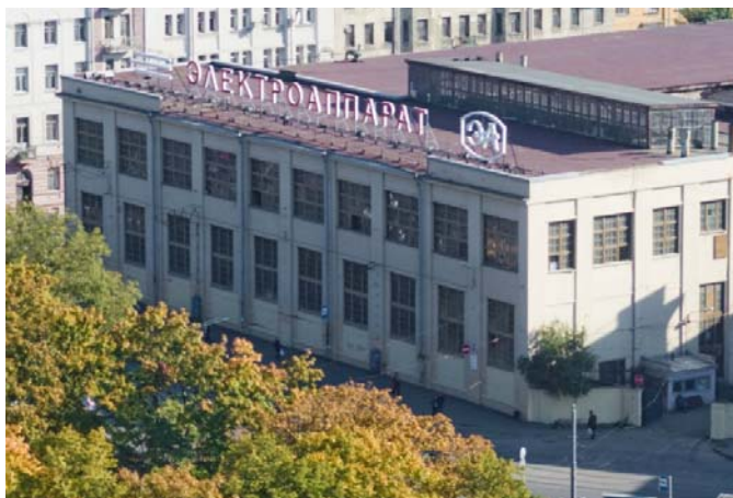
Рис 3. Акционерное общество высоковольтного оборудования «Электроаппарат»
