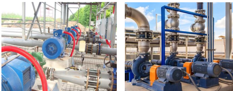
Рис. 6. Общий вид открытого насосного цеха.
