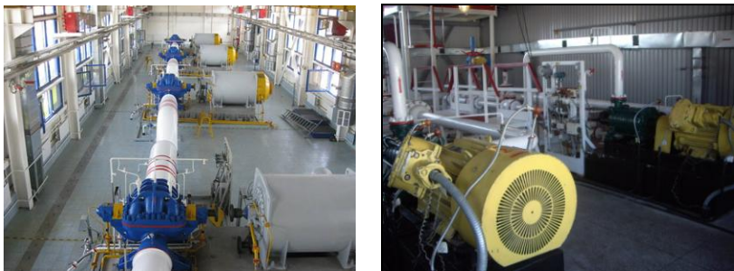
Рис. 5. Общий вид закрытого насосного цеха.
