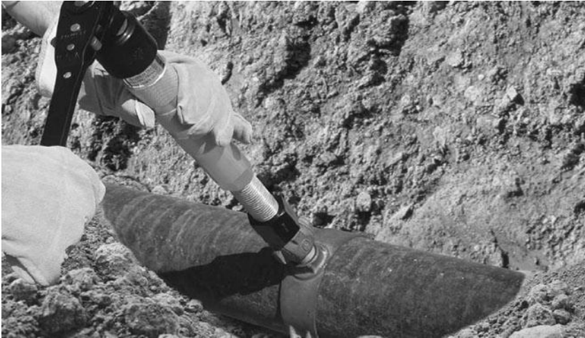
Рис. 4. Врезка в ПВХ трубопровод
