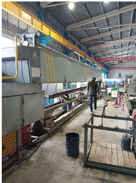
Рисунок 4.10 – Установка стенда Гидроиспытания УГ-1 на базе ООО «Перекрыватель»
