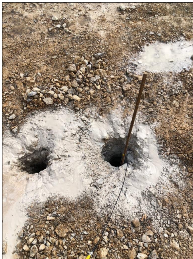
Рисунок 3.15 – Размещение датчика в скважине (фото автора)
