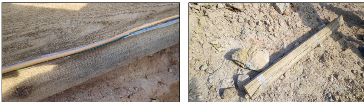
Рисунок 3.6 – Крепление отрезка ДШ с измерительным проводом (фото автора)
