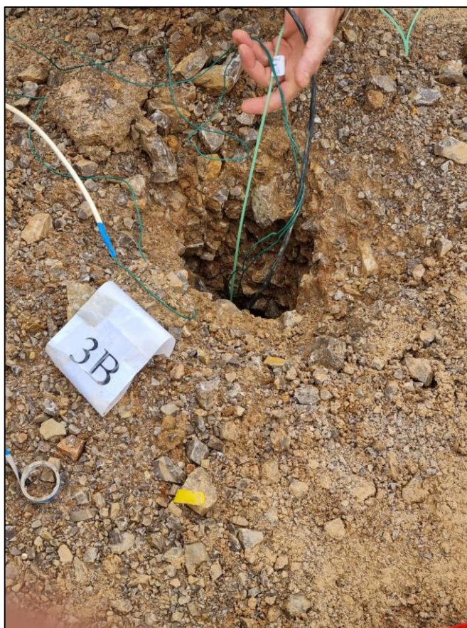
Рисунок 3.17 – Размещение кабелей в скважине (фото автора)
