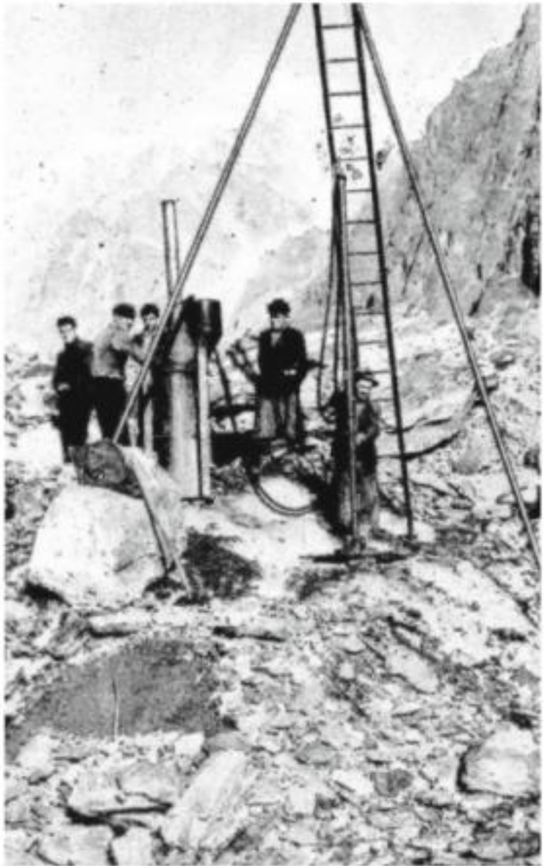
Рисунок 1.8 - Тепловое бурение в леднике Миаге, Альпы, 1942 г
