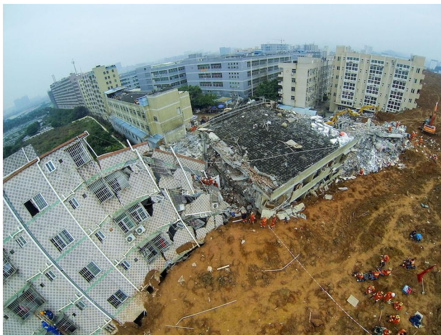
Рисунок 1.3 - Оползень в Шэньчжэне в 2015 г. (Китай)
