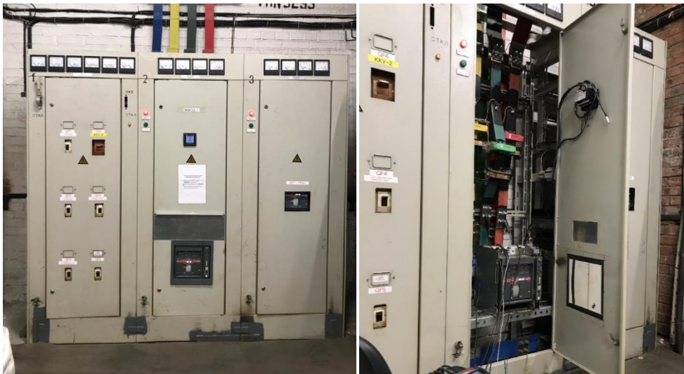
Рисунок 3.25 - Общий вид ТП и вводная ячейка для подключения измерительных приборов (фото автора)
