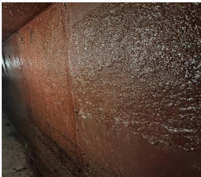
Рисунок 2.17 – Нанесение гидрогеля на вертикальные стенки (бока) учебного штрека
