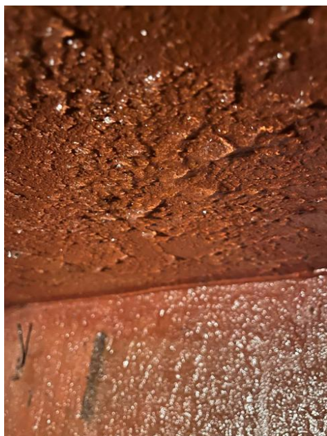
Рисунок 2.18 – Нанесение гидрогеля на горизонтальную поверхность (кровлю) учебного штрека
