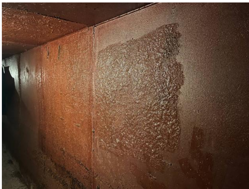
Рисунок 2.16 – Нанесение гидрогеля на вертикальные стенки учебного штрека
