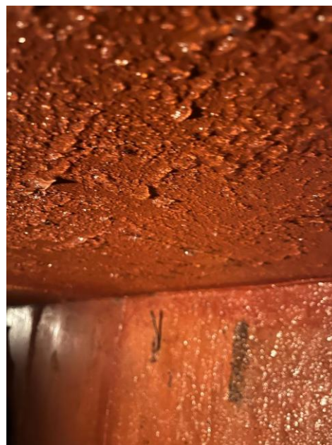
Рисунок 2.18 – Нанесение гидрогеля на горизонтальную поверхность (кровлю) учебного штрека
