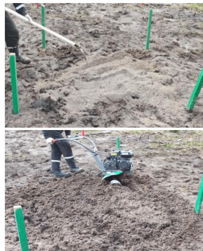
Рисунок 8 – Технология поверхностного распределения и механического перемешивания ТДМ в условиях нефтезагрязнённого грунта. Сверху – равномерное распределение ТДМ по поверхности; снизу – рыхление почвы с ТДМ
