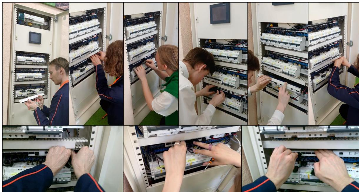
Рисунок 3 – Выполнение ТОиР распределительного электрического щита в лабораторном эксперименте
